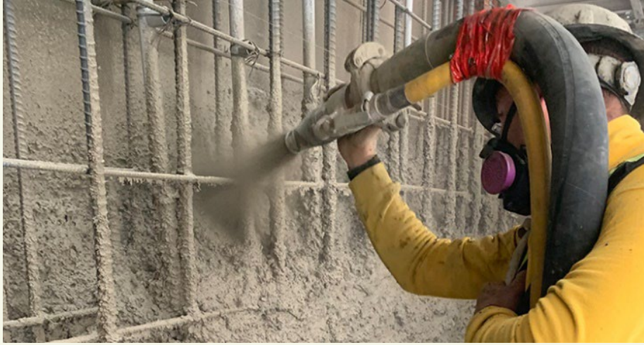
Şekil 1. Püskürtme beton uygulaması
