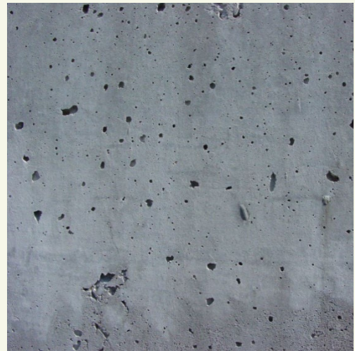
Şekil 4. Beton yüzeyinde oluşan hava boşlukları
