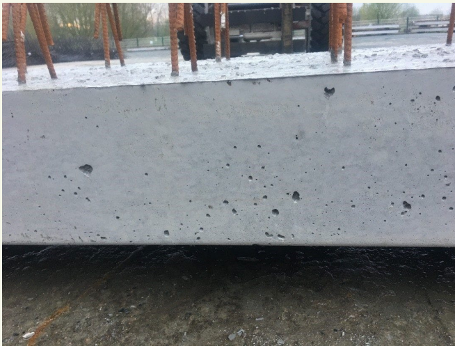
Şekil 4. Beton yüzeyinde oluşan hava boşlukları
