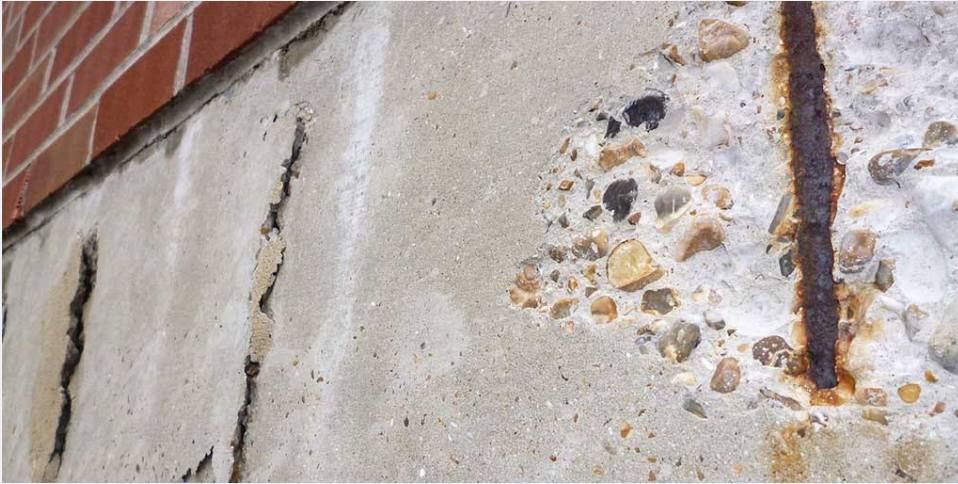
Şekil 1. Donatı korozyonu
