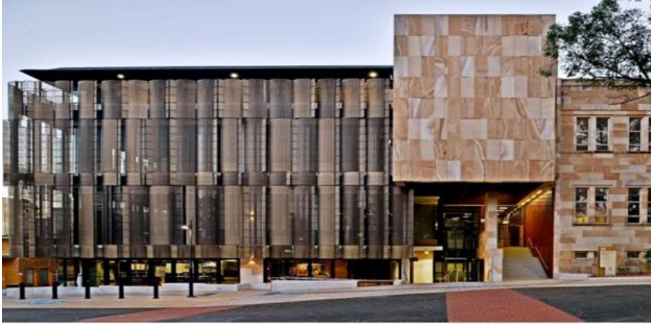
Resim 2. Geopolimer beton kullanılarak inşa edilen ilk bina 2013 yılında Avustralya'da bulunan Queensland Üniversitesi'ndeki Küresel Deđişim Enstitüsü (GCI) binasıdır.
