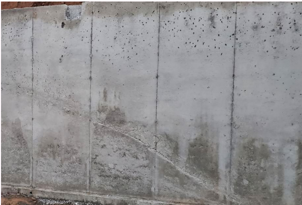
Şekil 1. Perde duvarda soğuk derz oluşumu
