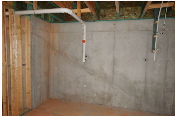
Şekil 1. Perde duvarda soğuk derz oluşumu
