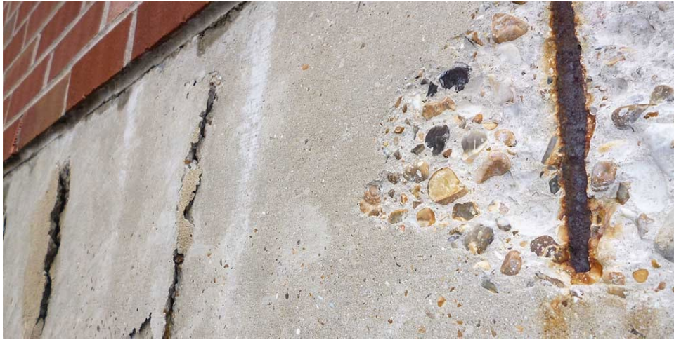
Şekil 9. Donatı korozyonu
