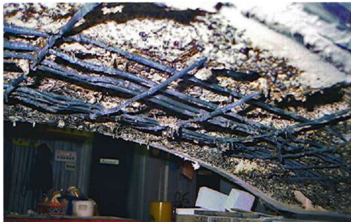
Şekil 17. Yüksek sıcaklıkta test edilen betonarme elemanda meydana gelen dökülme
