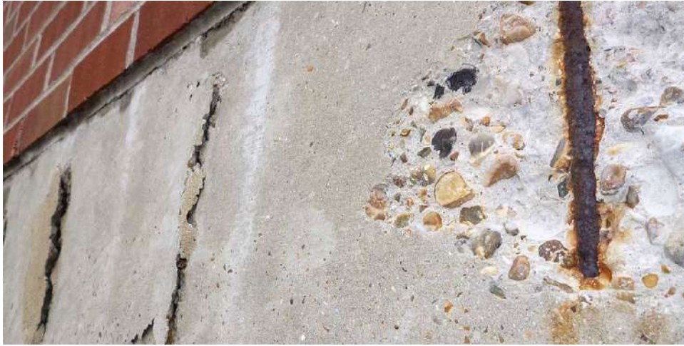
Şekil 9. Donatı korozyonu
