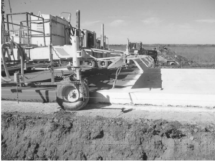
Şekil 3. Beton yolda kimyasal kür uygulaması
