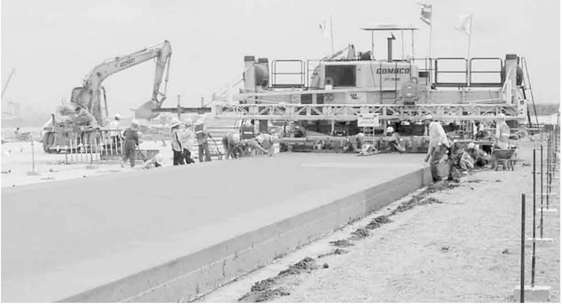
Şekil 1. Beton yol dökümü
