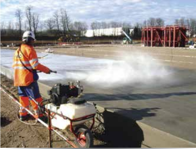
Şekil 3. Kür malzemesi uygulaması
