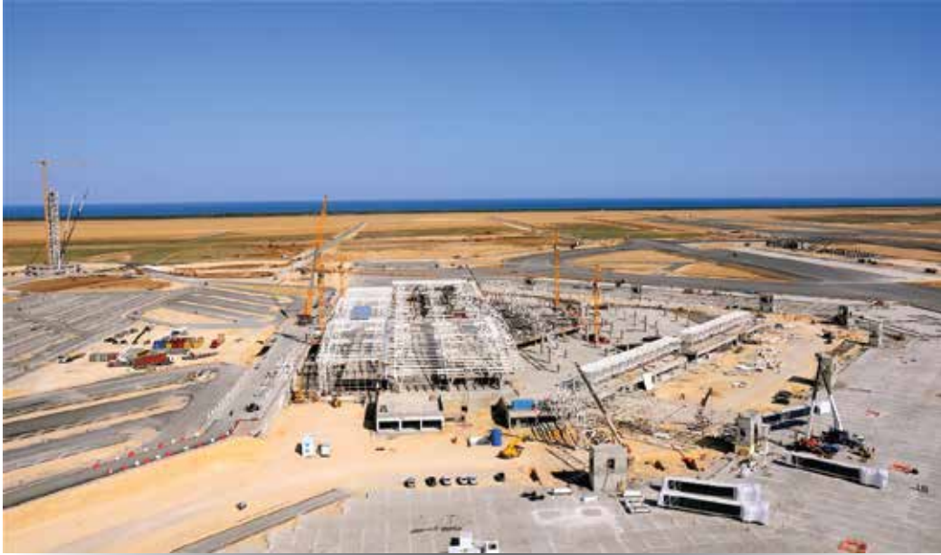
Şekil 1. Sıcak hava şartlarında beton dökümü
