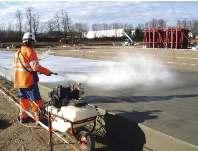
Şekil 3. Kür malzemesi uygulaması
