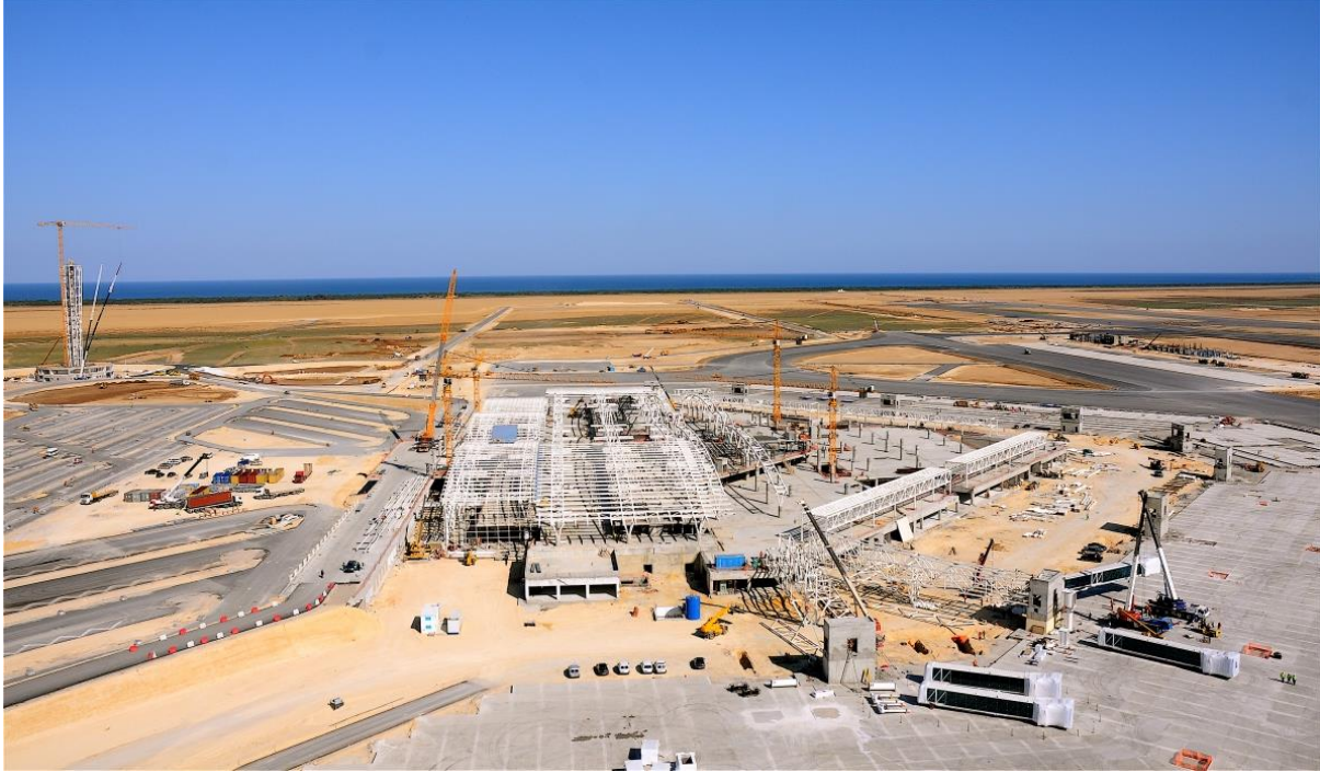
Şekil 1. Sıcak hava şartlarında beton dökümü
