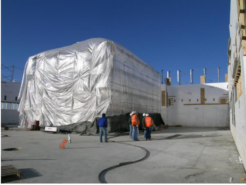
Őekil2: Soėuk Havada betonun korunması
