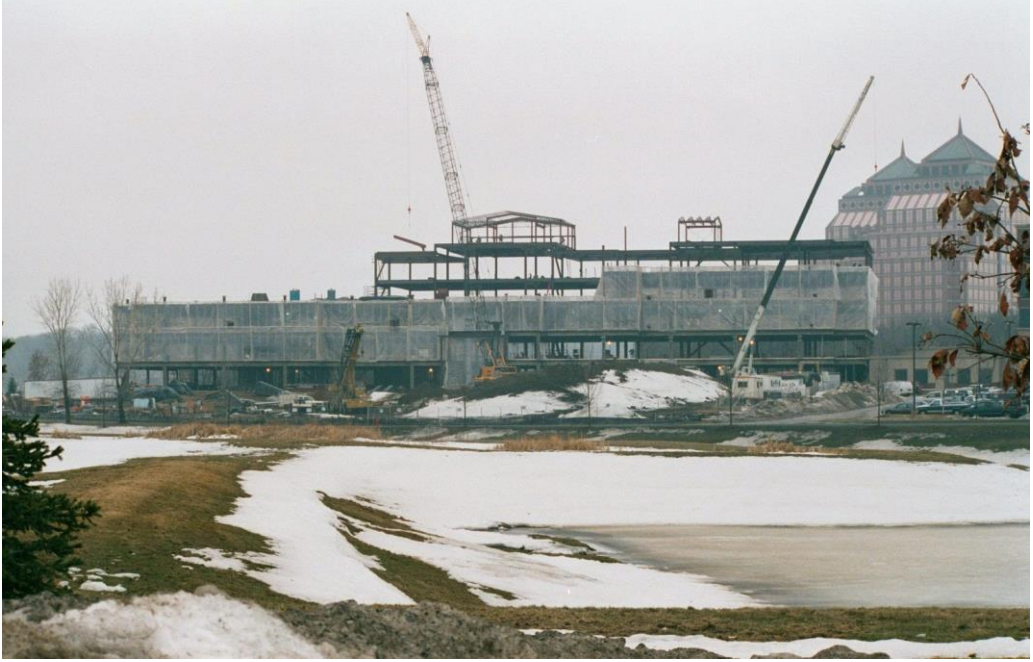
Şekil1: Soğuk Havada Beton dökümü
